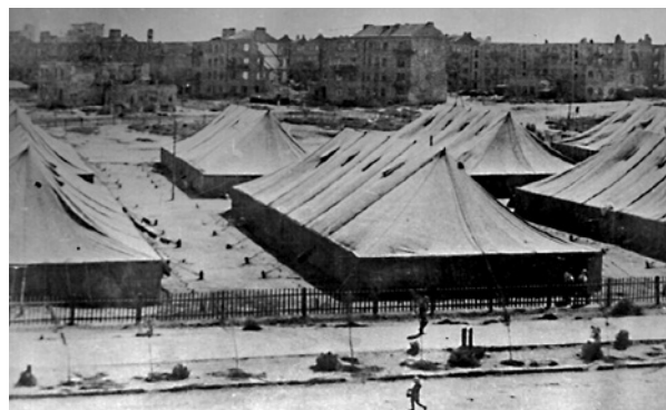
Рис. 64. Палаточный городок строителей в Верхнем поселке Сталинградского тракторного завода. Музей архитектуры Царицына–Сталинграда–Волгограда
