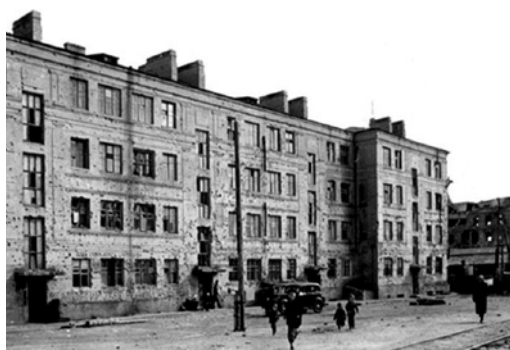
Рис. 77. Жилой дом Облпотребсоюза (Дом Павлова), восстановленный бригадой А. М. Черкасовой. Фото 1940-х годов. Музей архитектуры Царицына–Сталинграда–Волгограда
