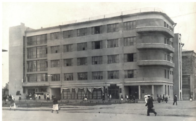
Рис. 130. Административная часть дома Легпрома (Местпрома) на углу пл. Павших Борцов и ул. Октябрьской. Архив В. И. Кочедамова, «Сталинградская папка»
