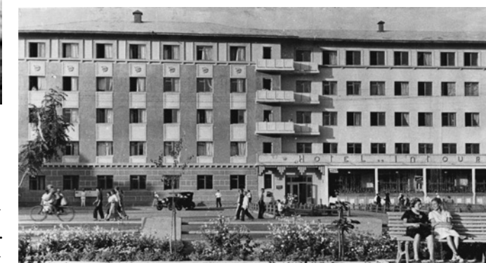
Рис. 141. Гостиница «Интурист» (1-я гостиница). Главный фасад. Архив Волгоградского дома архитекторов
