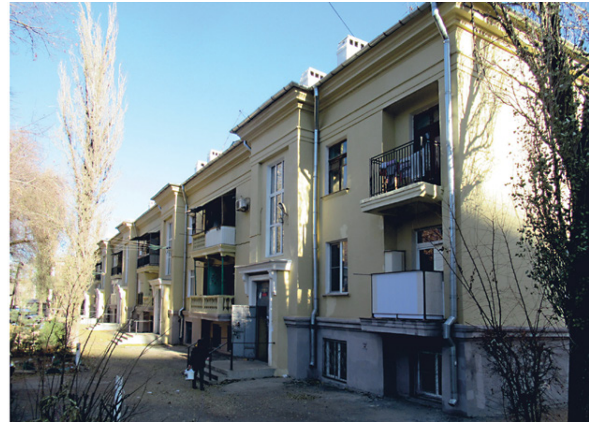
Рис. 88. Пример послевоенного восстановления типового внутриквартального жилого дома завода «Красный Октябрь»: два этажа вместо четырех. 2020 год. Фото: П. П. Олейников
