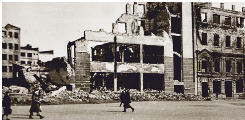
Рис. 155. Разрушенное здание гостиницы «Большая Сталинградская», справа — надстроенный дом бывш. пароходного общества «Русь» купца В. Ф. Лапина. Музей архитектуры Царицына–Сталинграда–Волгограда
