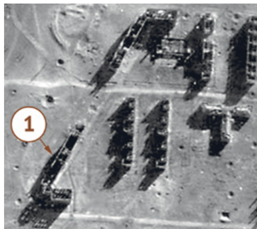
Рис. 69. Аэрофотосъемка 2 октября 1942 года. Разрушения в квартале № 20 Верхнего поселка завода «Красный Октябрь»: 1 – «Комсомольский дом». Музей архитектуры Царицына–Сталинграда–Волгограда
