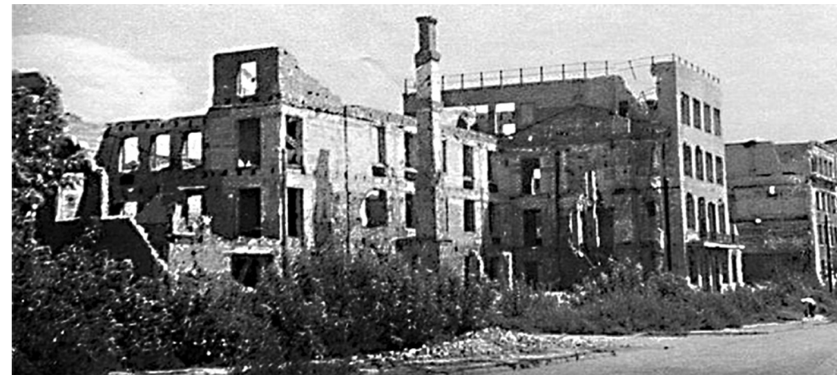
Рис. 227. Разрушенное во время Сталинградской битвы административное здание обкома ВКП(б) и облисполкома. Музей архитектуры Царицына–Сталинграда–Волгограда
