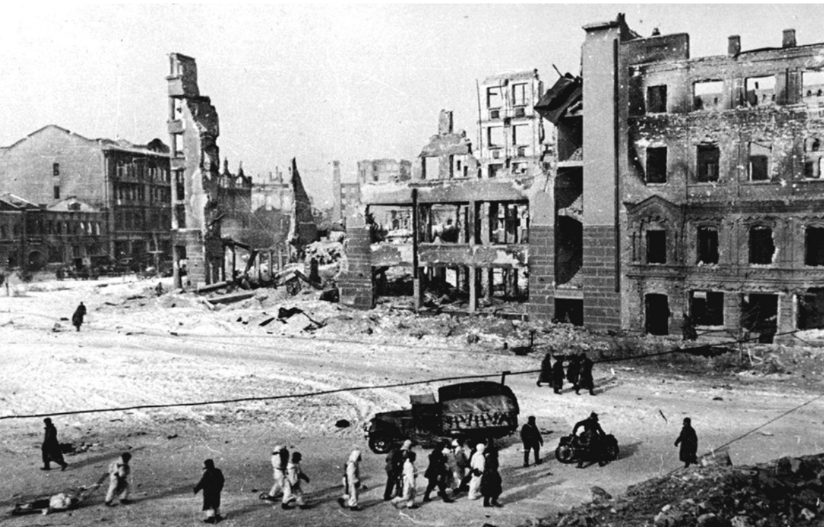
Рис. 62. Разрушенная гостиница «Большая Сталинградская». Музей архитектуры Царицына–Сталинграда–Волгограда
