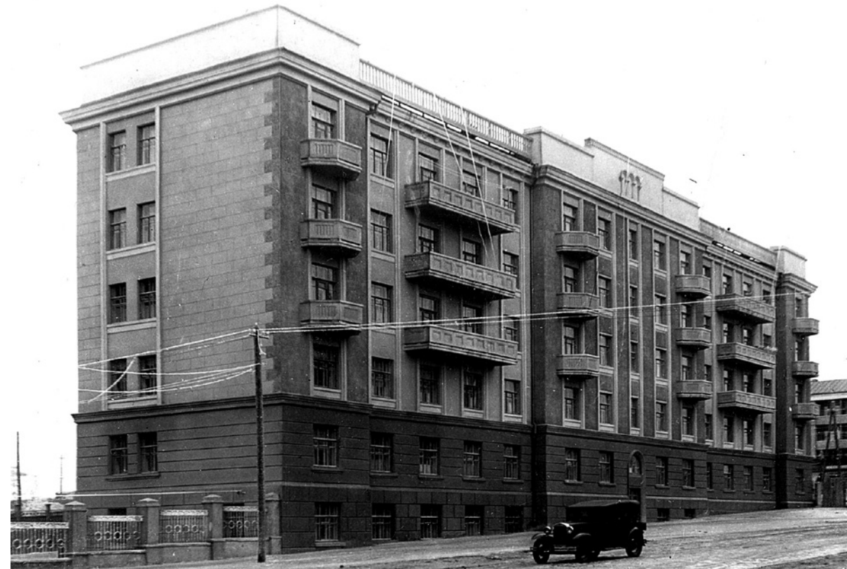
Рис. 170. Жилой дом НКВД на ул. Пензенской. Архит. В. И. Кочедамов. 1935 год. ГНИМА им. А. В. Шусева. КПнвф 279/20. Ежегодник ОАХ. Вып. XIV. 1935 г.
