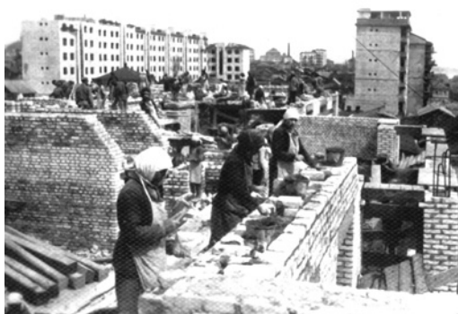
Рис. 113. Строительство корпуса «А» дома специалистов на 300 квартир. В глубине — корпус «А1» (справа) и корпус «В1» (слева). Музей архитектуры Царицына—Сталинграда—Волгограда
