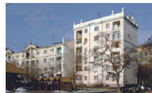
Рис. 121. Вновь отстроенный после войны корпус «А» жилого дома специалистов в Волгограде. Автор проекта восстановления архит. И. Е. Фиалко. 2020 год. Фото: П. П. Олейников
