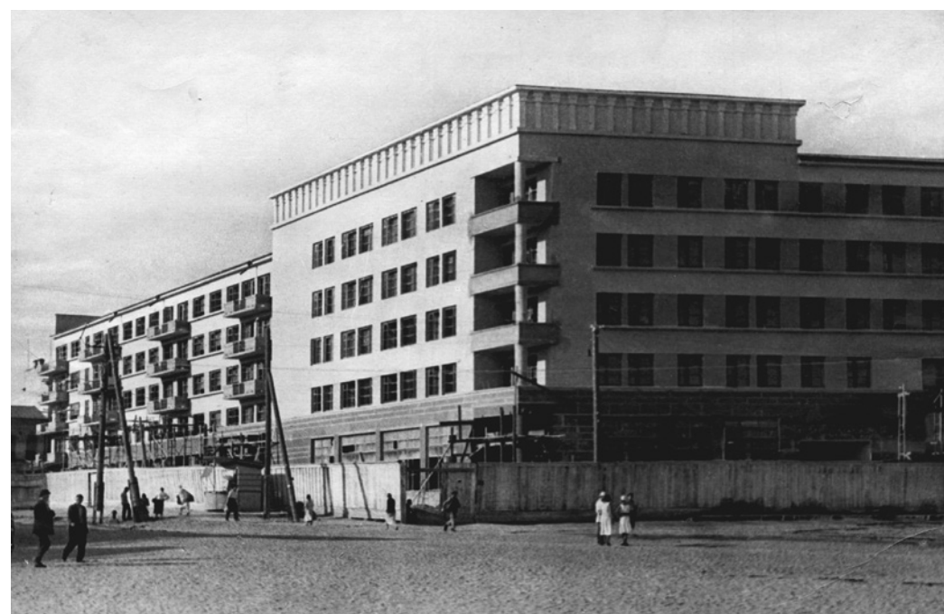
Рис. 150. Гостиница «Большая Сталинградская» в период строительства. 1934–1935 годы. ГНИМА им. А. В. Щусева. КПнеф 1121/4
