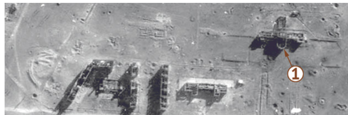
Рис. 95. Аэрофотосъемка 2 октября 1942 года. Разрушения в 20-м квартале Верхнего поселка завода «Красный Октябрь»: 1 — школа им. С. М. Кирова. Музей архитектуры Царицына–Сталинграда–Волгограда
