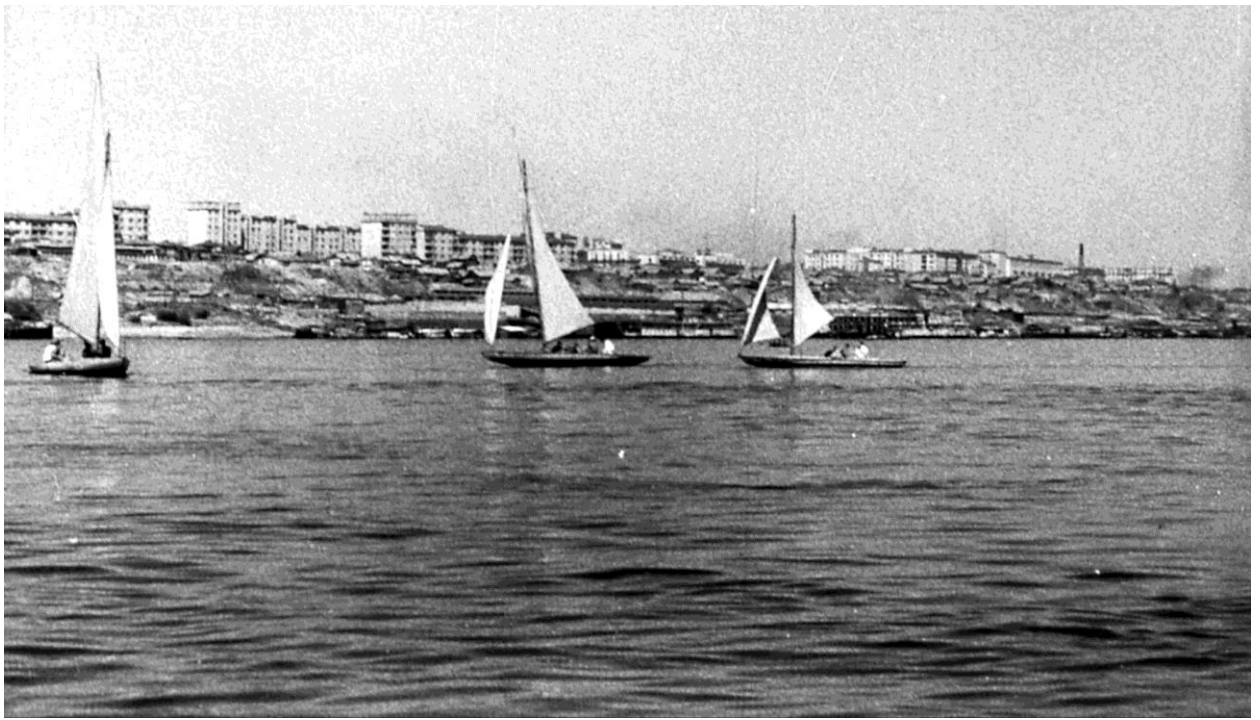
Рис. 5. Дома специалистов на 300 квартир в Сталинграде (слева). Вид с Волги. Архитекторы В. И. Кочедамов, И. В. Ткаченко
