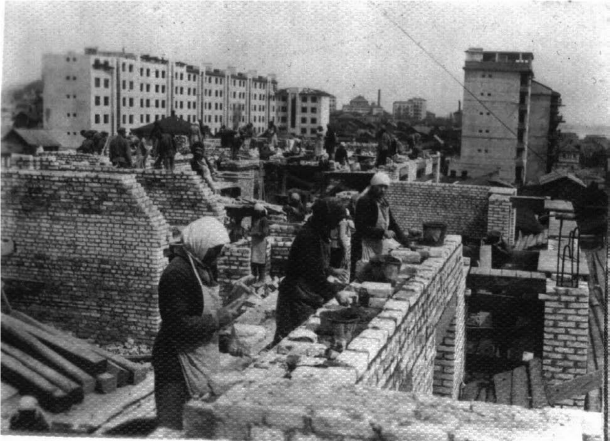
Рис. 3. Строительство корпуса «А» дома специалистов на 300 квартир в Сталинграде.
