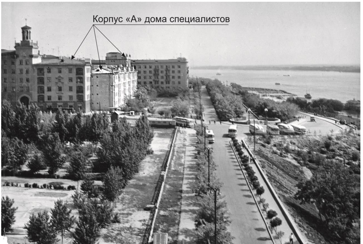
Рис. 8. Корпус «А» дома специалистов. Архитекторы В. И. Кочедамов, И. В. Ткаченко. 1932 г. Послевоенное восстановление. 1949 г. Архитектор И. Е. Фиалко
