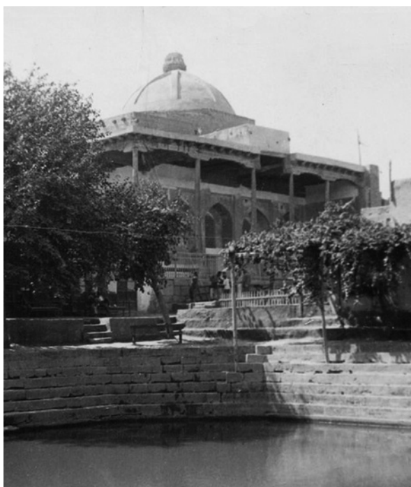
24. Хауз Ходжа-Зайнеддин в Бухаре. Общий вид
